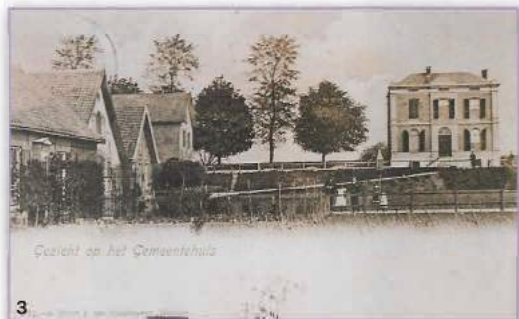
Gemeentehuis Heteren annex onderwijzerswoning aan de Kastanjelaan, gebouwd in 1876
