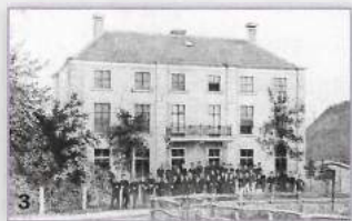
Schoolgebouw 1e Christelijk Gymnasium.
