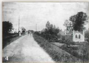
De "kroetfabriek" aan de Altena te Oosterhout
